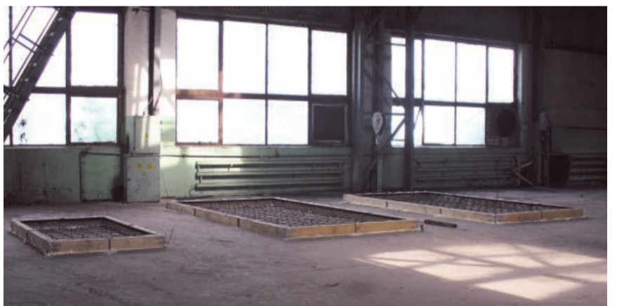
Площадка для новой заводской мини-котельной
